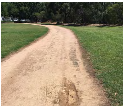
Existing gravel path & timber edge
