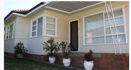
یک خانه کلاسیک دارای فیبرو با پوشش دیواری/رخ بام
