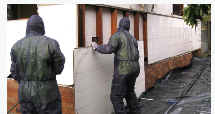
عملیات برداشتن آزبست با رعایت ایمنی*
