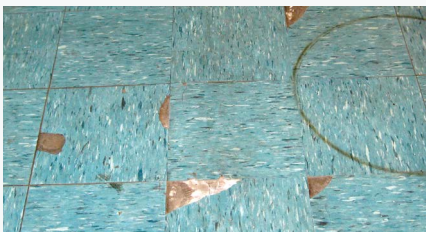
کف پوش وینیل خسارت دیده حاوی آزبست*
